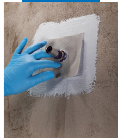
Einbau einer Mapeband PE 120 Wanddichtmanschette mit Mapegum WPS
