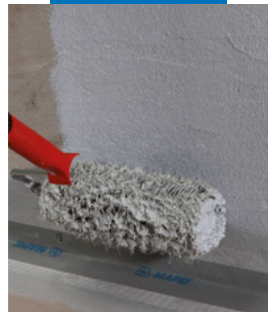
Auftragen von Mapegum WPS mit einer Rolle
