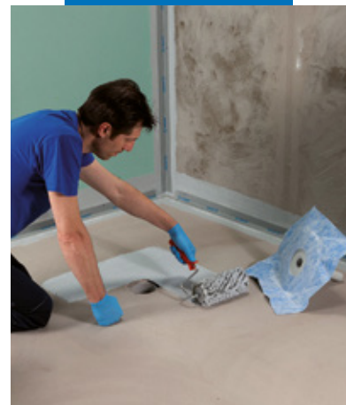
Einbau eines Bodenablaufs mit Mapegum WPS
