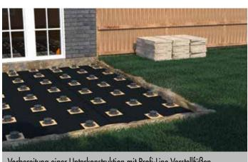
Vorbereitung einer Unterkonstruktion mit Profi-Line Verstellfüßen
