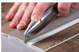
Vor dem Nahtschnitt (Doppelschnitt) auf die untere und obere Bahn im Schnittbereich ein glattes, gegenüber unserem Kaltschweißmittel und Temperatur beständiges Klebeband aufbringen. Die überlappend ausgelegten Belagsbahnen (3–5 cm) werden gleichzeitig in einem einzigen Schnitt entlang einer Metallschiene durchgeschnitten (Doppelschnittverfahren).
