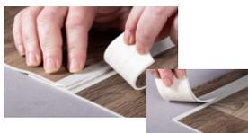
Nach dem Doppelschnitt sind die Schnittreste der oberen und der unteren Belagsbahn zu entfernen.
