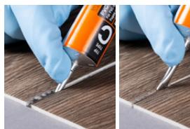
Nahtbereich säubern (Kleberreste, Schmutz usw.), ggf. hoch stehende Nähte nachkleben. Mit der Tube langsam in der Naht entlangfahren und so dosieren, dass die PVC-Kaltschweißpaste die Fuge vollständig ausfüllt.
