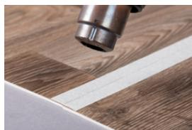
Bei wenig flexiblen PVC-Bodenbelägen (z. B. bei Objektbelägen) ermöglicht das Erwärmen des Nahtbereichs (max. 40 °C mittels Föhn oder Bügeleisen) vor der Verschweißung ein leichteres und gleichmäßigeres Führen der Nadel in der Naht.
