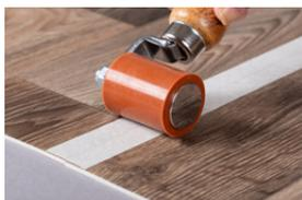
Das Papierklebeband fest auf den PVC-Bodenbelag anpressen, damit kein Kaltschweißmittel unter das Klebeband laufen und die Belagsoberfläche beschädigen kann.
