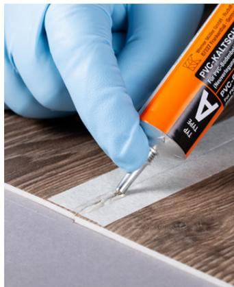
Arbeiten Sie immer mit beiden Händen! Halten Sie die Tube so, dass der Zeigefinger einer Hand auf der Kanüle liegt und die andere Hand die Tube hält.
