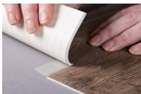
Falls der PVC-Belag nicht vollflächig auf dem Boden verklebt wird (bitte beachten Sie hierzu die Angaben der Bodenbelagshersteller), so ist der Nahtbereich mit einem geeigneten, doppelseitigen Klebeband am Unterboden zu fixieren. Die PVC-Belagsbahnen dicht aneinander liegend gut andrücken.
