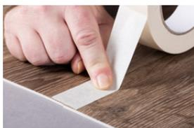
Ein gegenüber unserem Kaltschweißmittel und Temperatur beständiges, glattes Papierklebeband mittig auf die dicht geschnittene Naht kleben und fest auf den PVC-Bodenbelag anpressen, damit kein Kaltschweißmittel unter das Klebeband laufen und die Belagsoberfläche beschädigen kann.
