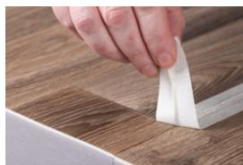
Das Klebeband ca. 10 Minuten nach der Verschweißung schräg nach hinten abziehen. Quellungen des PVC-Belages im Nahtbereich gehen zurück. Die Naht kann nach ca. 30 Minuten begangen werden.
