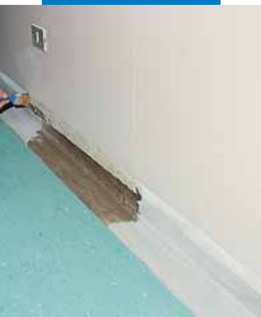
Verarbeitung von Adesilex LP im Wandbereich
