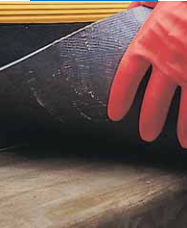
Verlegen von Gummi-Formstufen mit Adesilex LP
