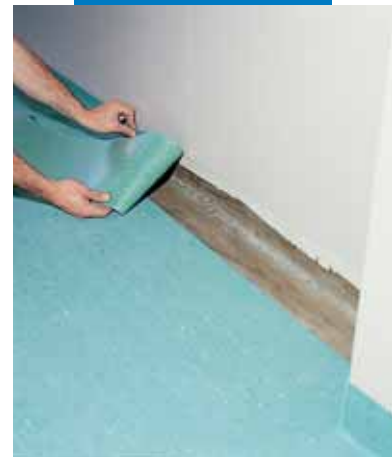
Verlegung eines PVC-Belages als Hohlkehlssockel
