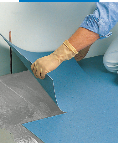
Verlegung von PVC-Platten mit Ultrabond Eco V4 SP Conductive
