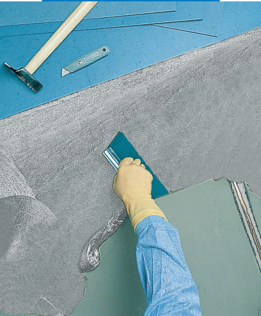
Verarbeitung von Ultrabond Eco V4 SP Conductive
