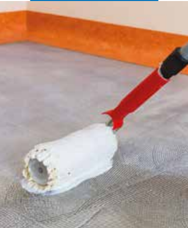
Auftragen von Eco Prim T Plus mit einer Rolle
