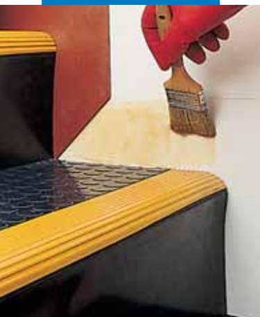
Klebung von Gummisockeln mit Adesilex LP
