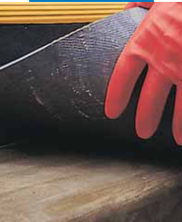
Verlegen von Gummi-Formstufen mit Adesilex LP
