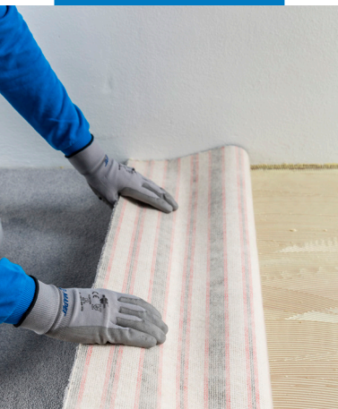
Verlegung von Tuftingbelag
