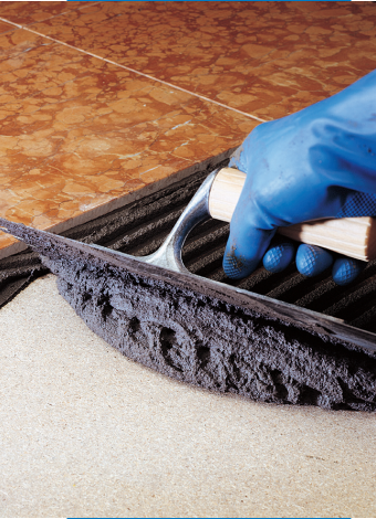
Spachteln von Fugen in Holzböden mit Nivorapid + Latex Plus
