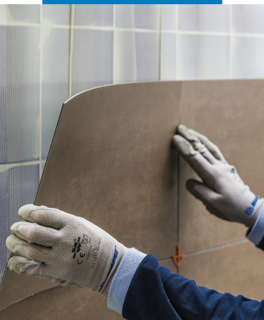
Verlegen von Designbelag an der Wand
