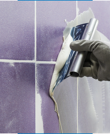
Auftragen von Ultrabond Eco MS 4 LVT Wall mit einem Zahnpachtel auf einem nichtsaugenden Untergrund
