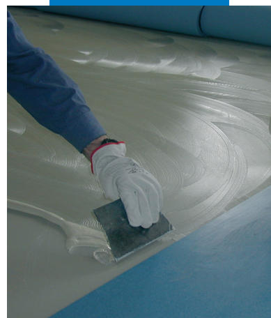
Auftragen von Ultrabond Eco V4SP im San Martino Altersheim – Italien
