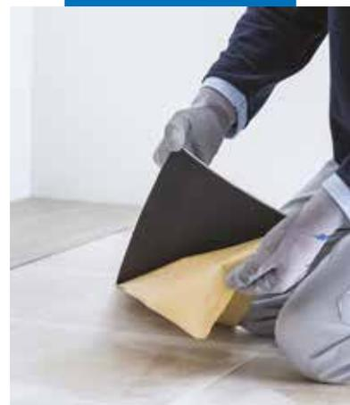
Entfernen der Schutzfolie von der Rückseite eines selbstklebenden PVC-Designbelages
