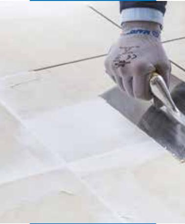
Spachteln und Verschließen von Fugen in einem bestehenden Fliesenbelag mit Planiprep 4 LVT
